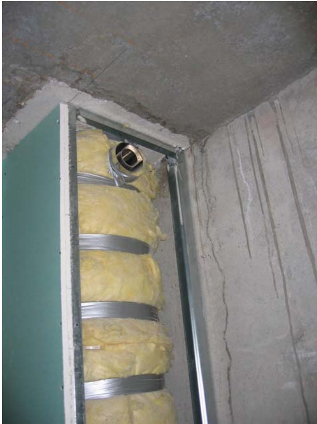
Рисунок 3. Бетонная пробка, изоляция из минеральной ваты, металлические основы обкладки и обкладка из гипсовых плит.
